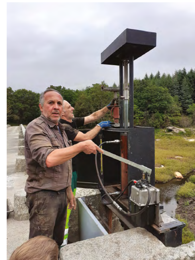
Patrick Folch ferme la vanne permettant de remplir à nouveau le bassin après plusieurs mois de travaux.
